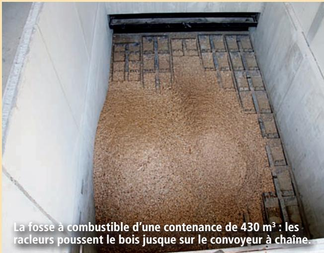
La fosse à combustible d'une contenance de 430 m<sup>3</sup> : les racleurs poussent le bois jusque sur le convoyeur à chaîne.
