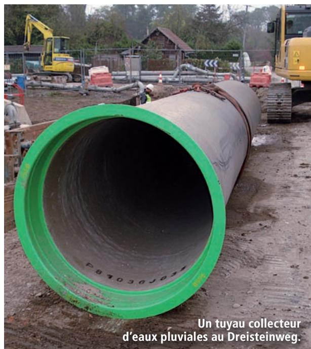
La première tranche de travaux réalisée en 2010 – 2011 permet de collecter 1,6 ha de voirie. A terme un réseau d'eaux pluviales de diamètre 300 mm à 1200 mm collectera les 2,9 ha de voirie. Les eaux pluviales sont traitées par un ouvrage de séparation d'hydrocarbures qui permet leur rejet dans la Lauch.
