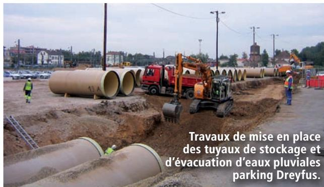
Travaux de mise en place des tuyaux de stockage et d'évacuation d'eaux pluviales parking Dreyfus.
