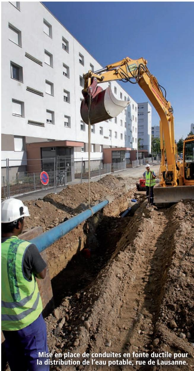
Mise en place de conduites en fonte ductile pour la distribution de l'eau potable, rue de Lausanne.
