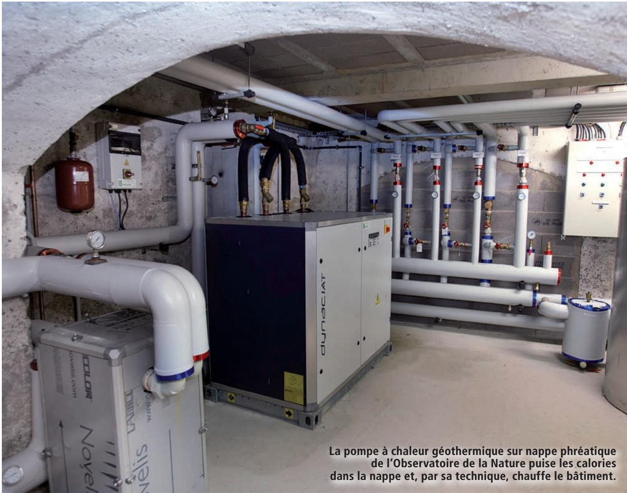
**La pompe à chaleur géothermique sur nappe phréatique de l'Observatoire de la Nature puise les calories dans la nappe et, par sa technique, chauffe le bâtiment.**
