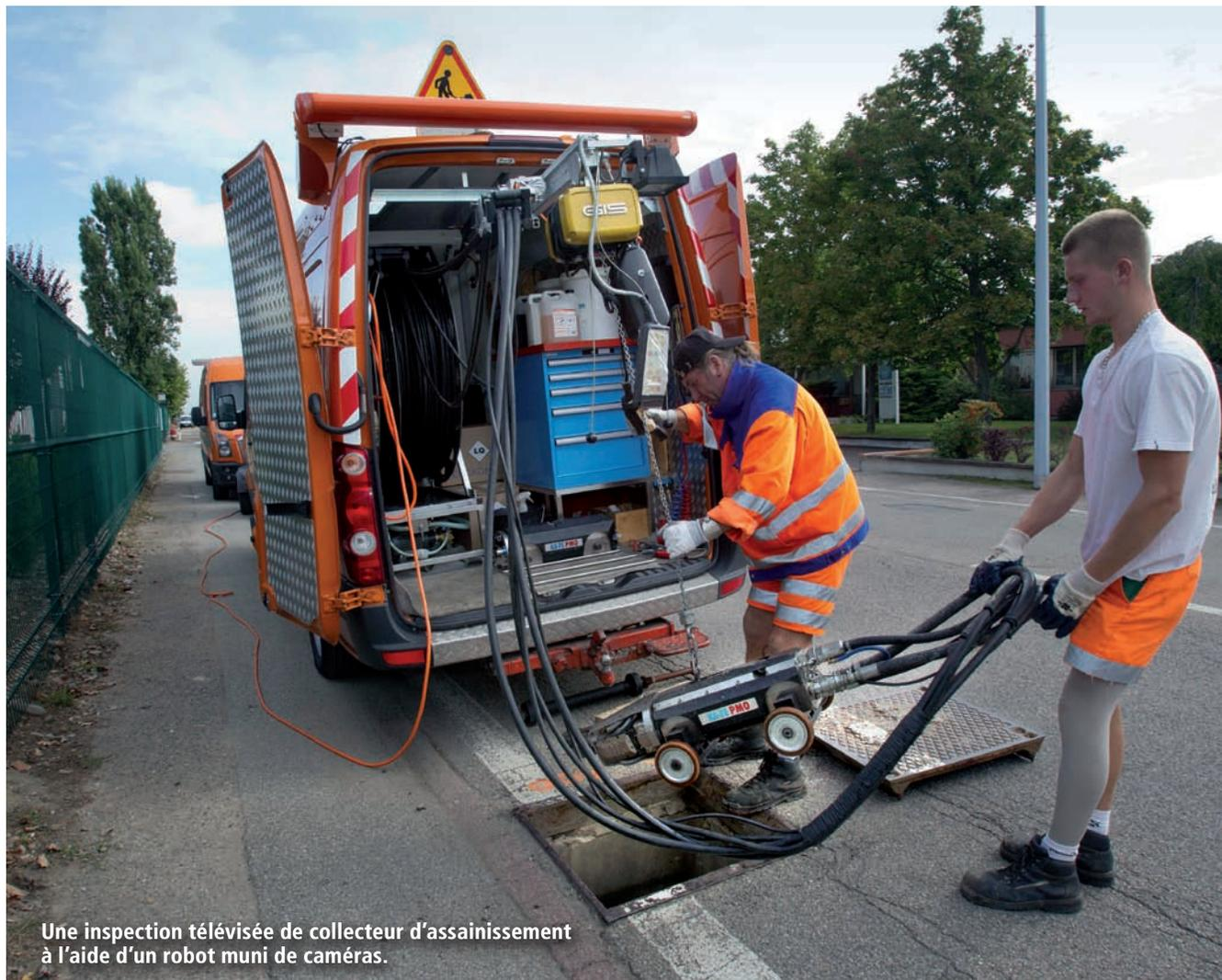
Une inspection télévisée de collecteur d'assainissement à l'aide d'un robot muni de caméras.
