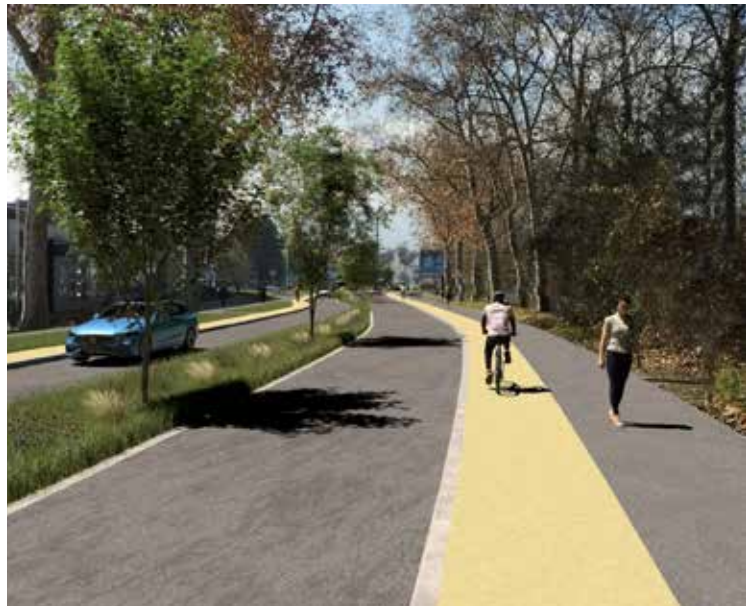
Le réaménagement de la route de Neuf-Brisach inclut la séparation des voies cyclable et piétonne.
