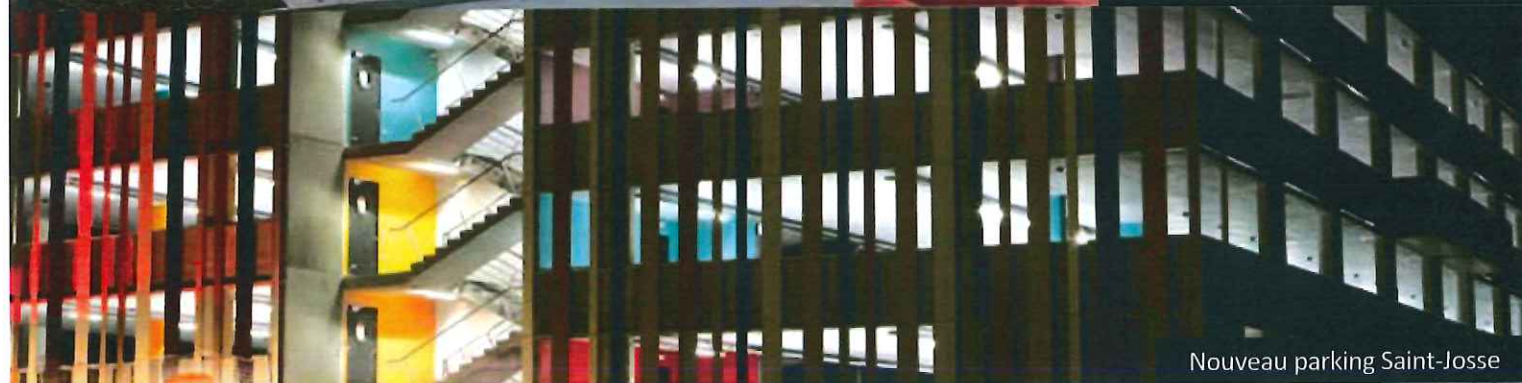
Restructuration du Centre Europe
