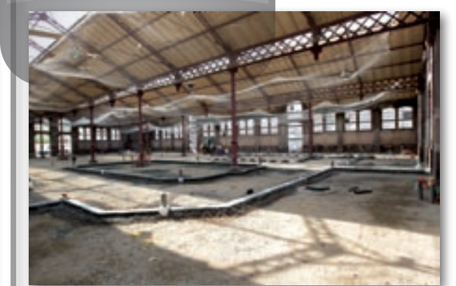
Marché couvert : 1 080 000 € Transformation en marché permanent Coût total à terme : 1,84 M€
