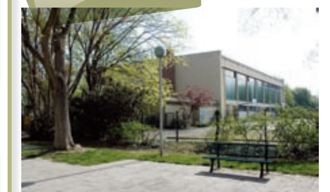
Gymnase Grillenbreit : 93 900 € Frais d'études Coût total à terme : 2,8 M€
