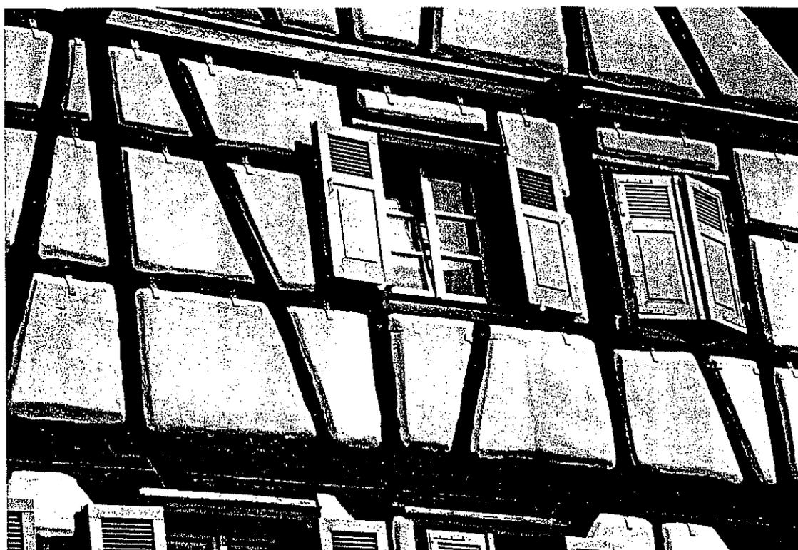
Les plaques d'enduit, trop épaisses et trop lourdes risquent de se décrocher des façades. Il a fallu les maintenir par des étriers métalliques.
