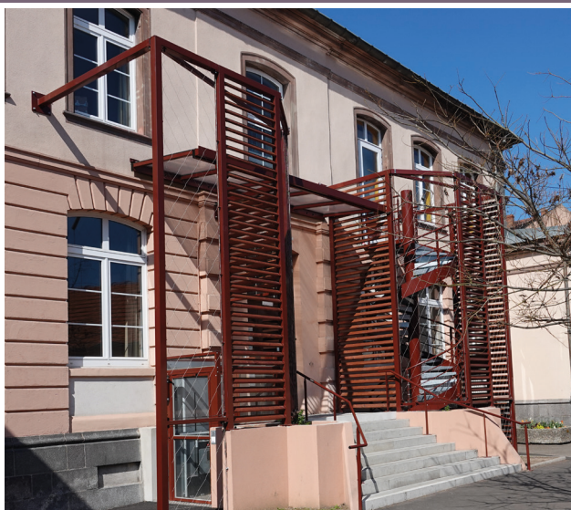
Travaux d'accessibilité à l'école Hirn
