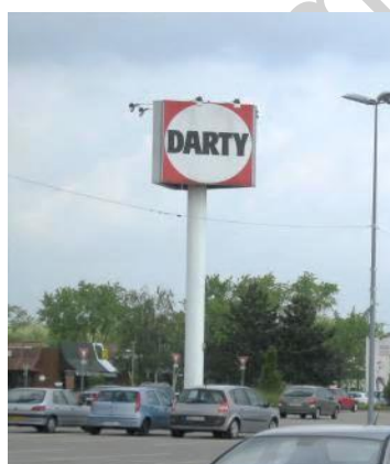
Dispositif scellé au sol « caisson sur mât »
