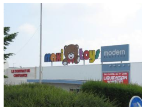
Dispositif apposé sur toiture terrasse
