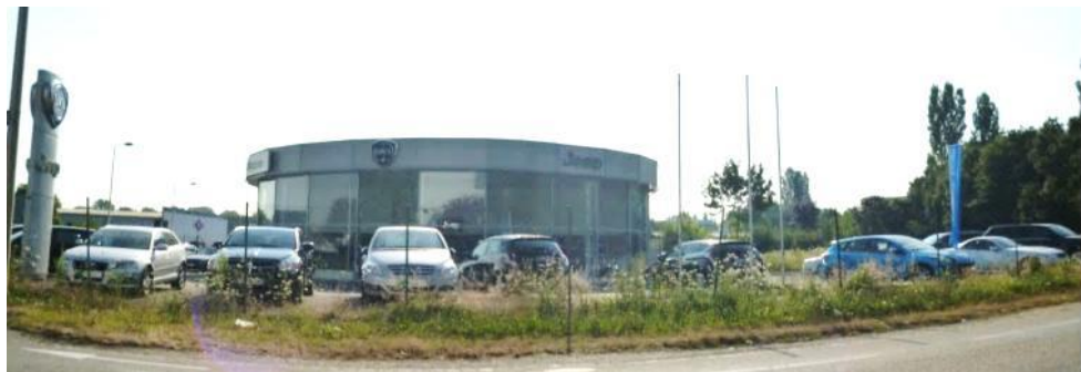
Vues 9, 10 et 11 : le Nord de la rue du Ladhof – majorité de grandes emprises d'activités industrielles et artisanales
