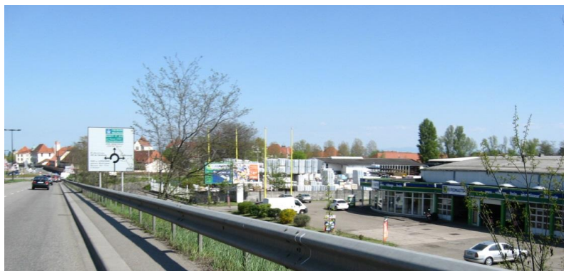
En entrée depuis l'Avenue de Lorraine : des vues sur les bâtiments, les aires de stockage et de stationnement, les enseignes et les panneaux publicitaires. L'ensemble présente une hétérogénéité peu qualitative en entrée de ville.
