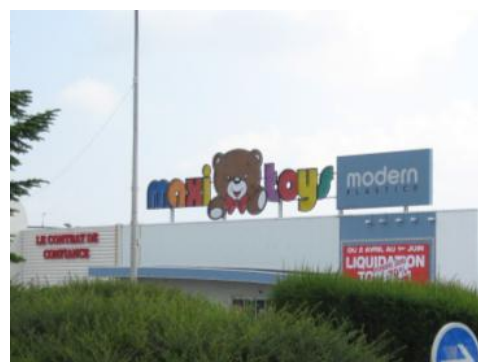
Dispositif apposé sur toiture terrasse
