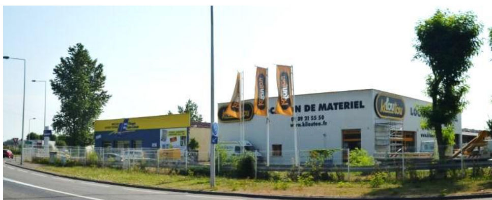
Vues 4,5 et 6 : secteur commercial au Sud de l'avenue J. Rey – présence d'enseignes de type oriflammes
