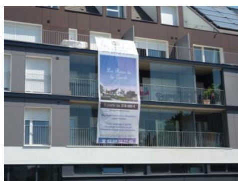
Bâche publicitaire – affichage temporaire d'opération immobilière (devant des baies d'appartements occupés)
