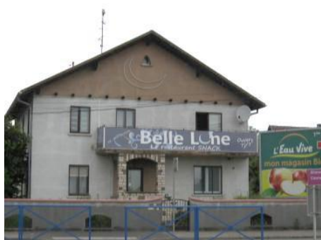
Dispositif apposé sur le garde-corps d'un balcon
