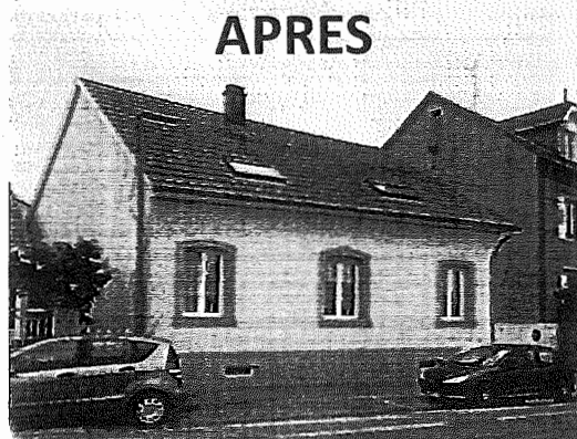
Façade après réalisation des travaux de ravalement
