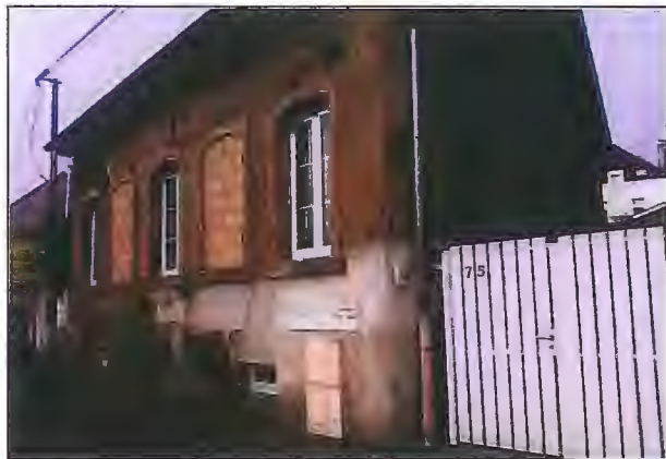
Façade avant réalisation des travaux de ravalement
