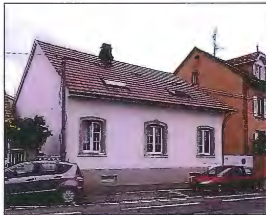
Façade après réalisation des travaux de ravalement
