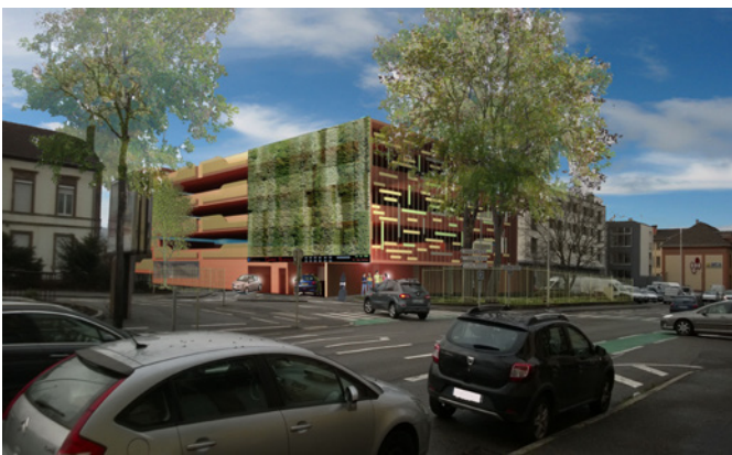
Gare de Colmar : construction du parking Gare/Bleyle
