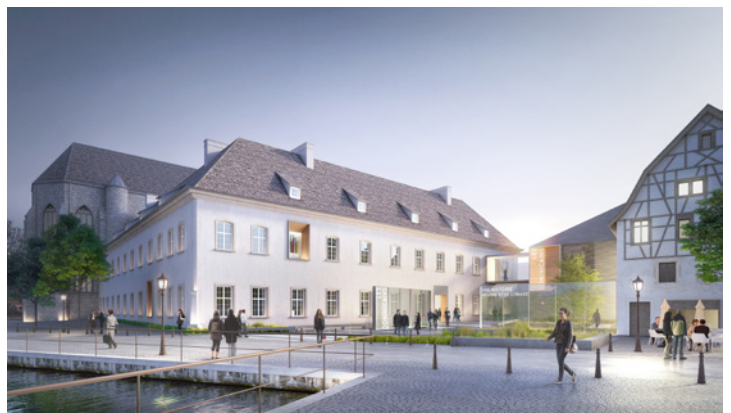
Centre - ville : restauration des Dominicains de Colmar
