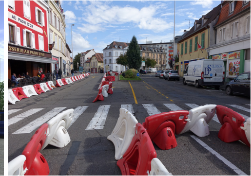
Centre - ville : aménagement place du saumon
