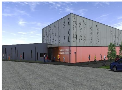
Gymnase du Grillenbreit
