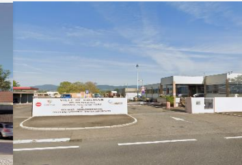
Restructuration parc et atelier municipaux
