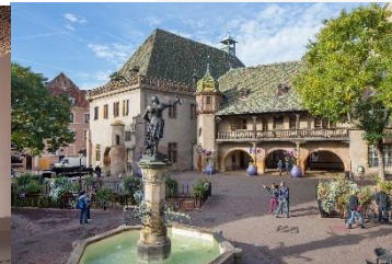
Restauration complète du Koifhus
