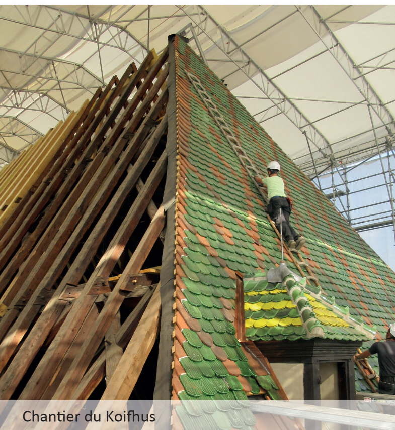
Chantier des Dominicains
