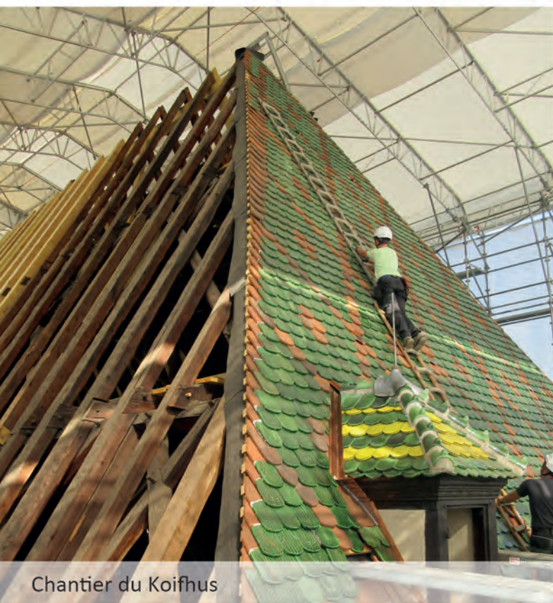
Chantier des Dominicains
