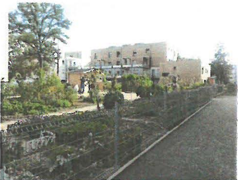
Jardin partagé – Construction 15 logements
