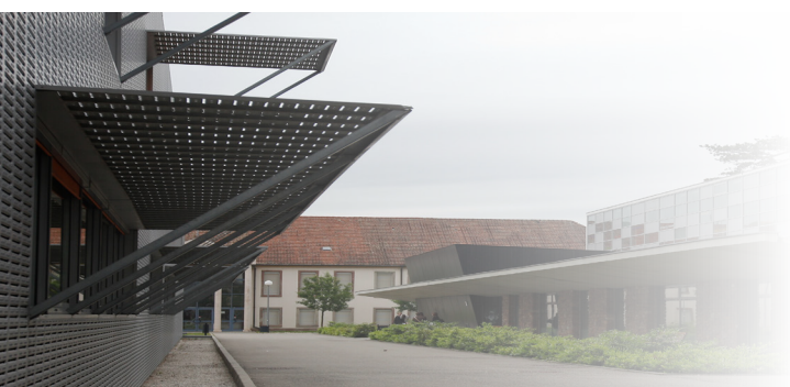
Campus du Grillenbreit : construction d'un gymnase
