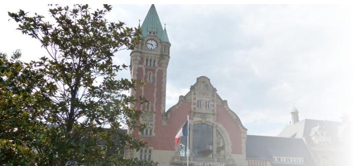
Construction d'un parc de stationnement à la gare
