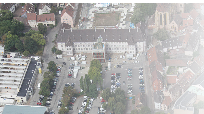
Montagne Verte : construction d'un parking souterrain
